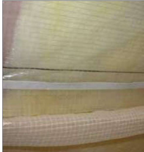
2. Наклеїти стрічку на нижній шар пароізоляції
