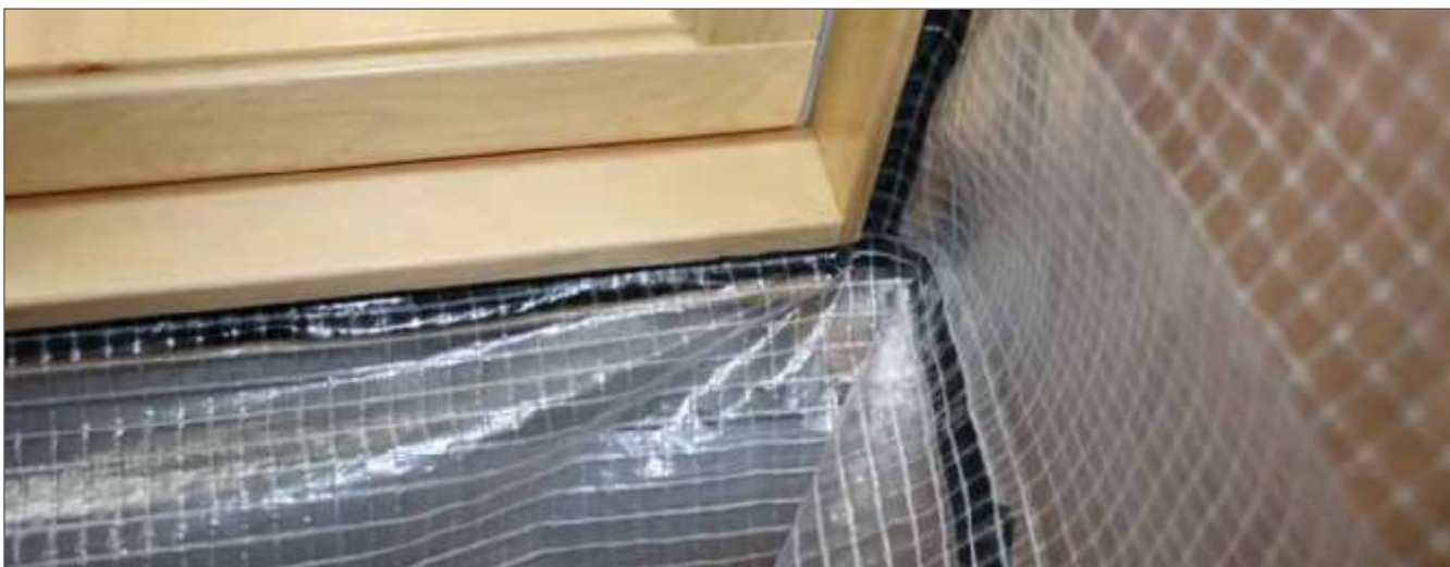
5. Герметизація нижнього кута
