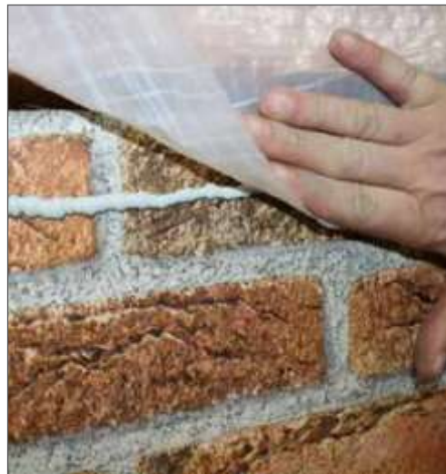
6. Щільно приклеїти пароізоляційну плівку
