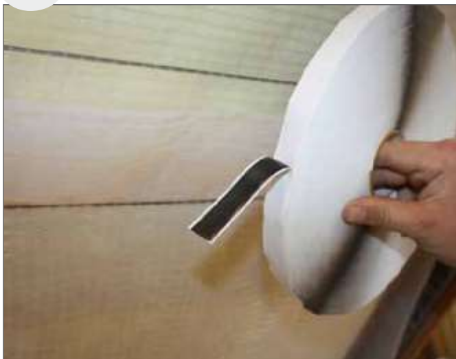
1. Використовувати двосторонню бутилкаучукову стрічку
