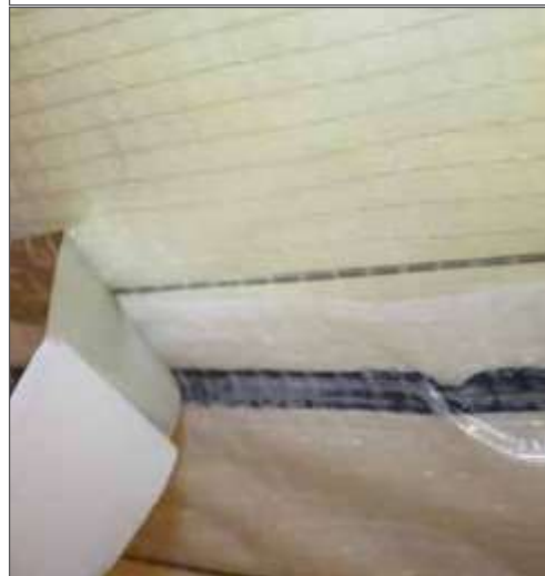
6. Проклеїти край перекриття алюмінієвою стрічкою для щільної герметизації
