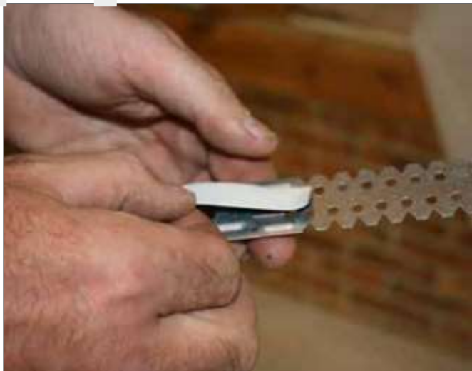
1. Використовувати бутилкаучукову двосторонню стрічку
