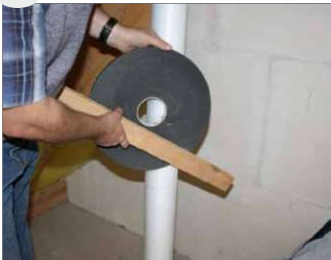
1. Використовувати двосторонню бутилкаучукову стрічку
