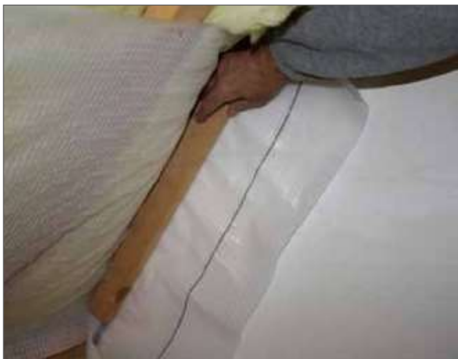
4. Ущільнити дерев'яною планкою
