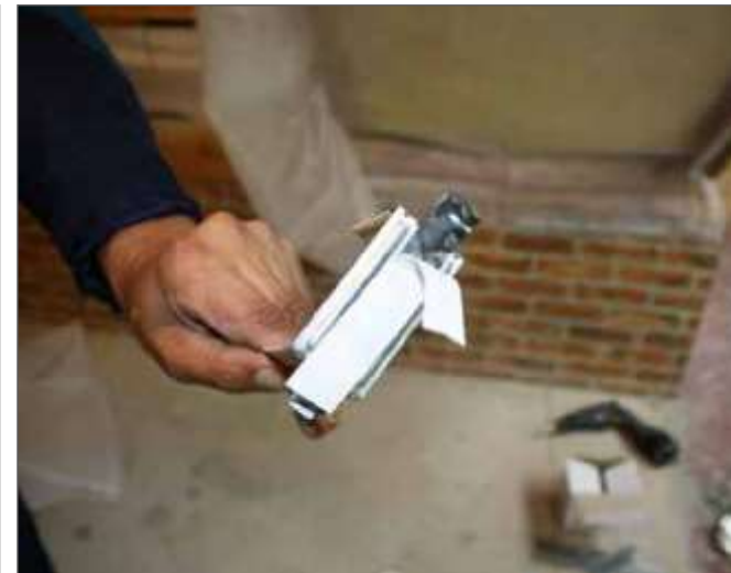
3. Готовий клямер для монтажу на пароізоляцію
