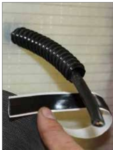
7. Використовувати бутилкаучукову двосторонню стрічку
