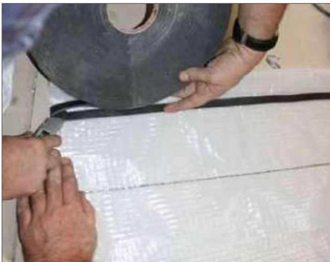
2. Наклеїти стрічку на край пароізоляційної плівки
