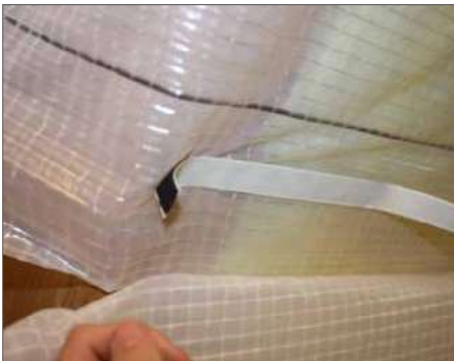
2. Наклеїти стрічку на нижній шар пароізоляції
