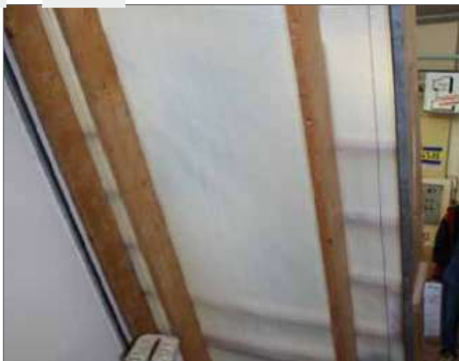
1. Визначити місце для вирізу у полотні пароізоляції під установку мансардного вікна
