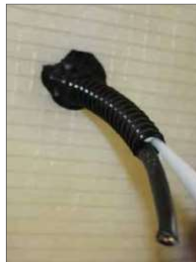
9. Герметизувати спеціальною мастикою місце проходу кабелю через обмотку
