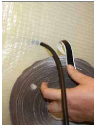
2. Використовувати бутилкаучукову двосторонню стрічку
