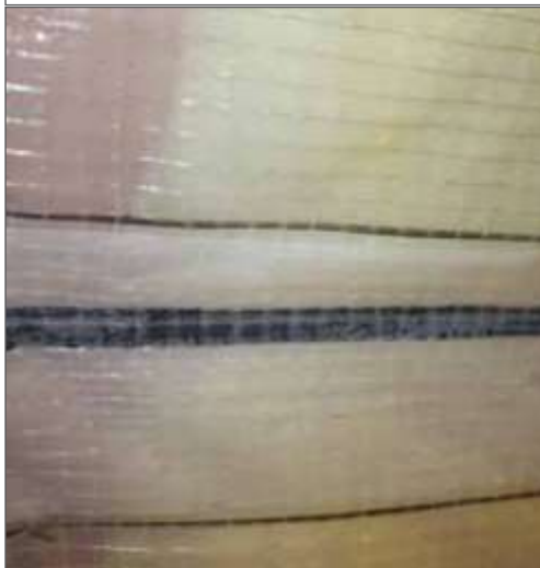
5. Щільно приклеїти верхнє перекриття пароізоляції
