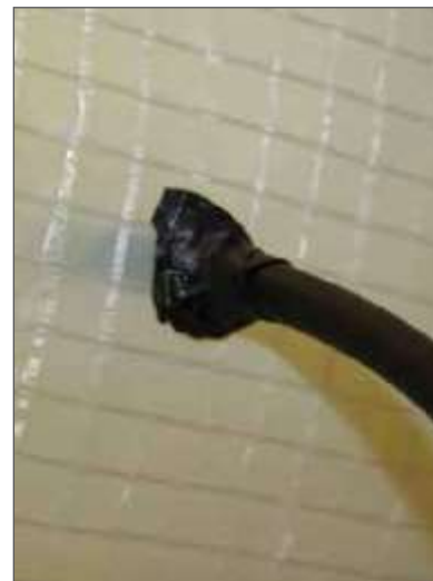
4. Приклад герметизації вузла
