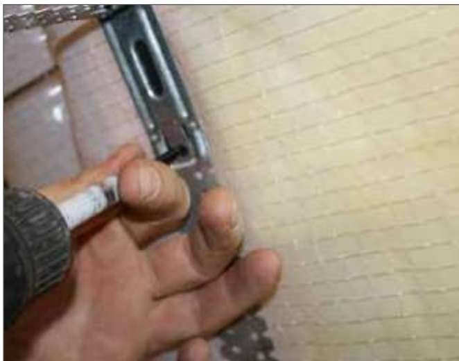
4. Монтувати клямер до дерев'яних конструкцій через пароізоляцію
