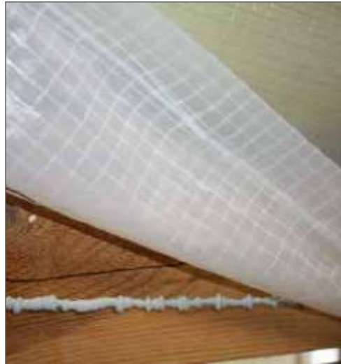
3. Щільно приклеїти пароізоляційну плівку
