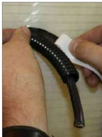
8. Герметизувати по колу місце проходу обмотки кабелю
