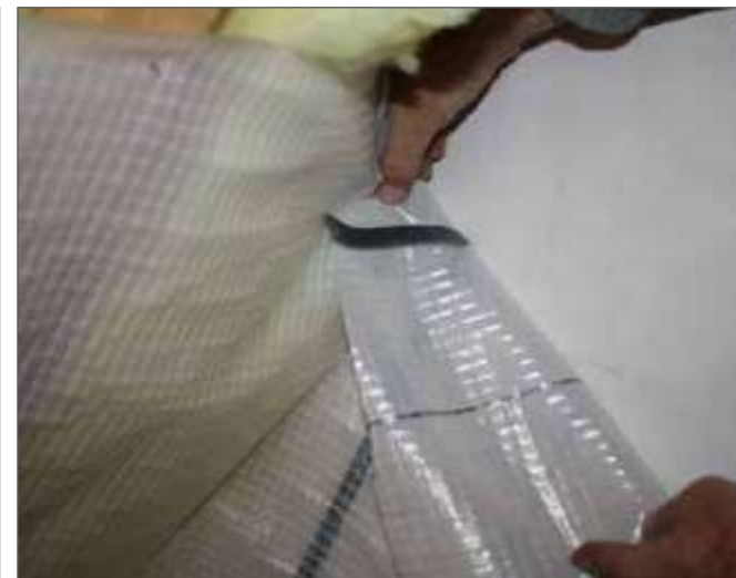
3. Приклеїти плівку зі стрічкою до стіни або примикання
