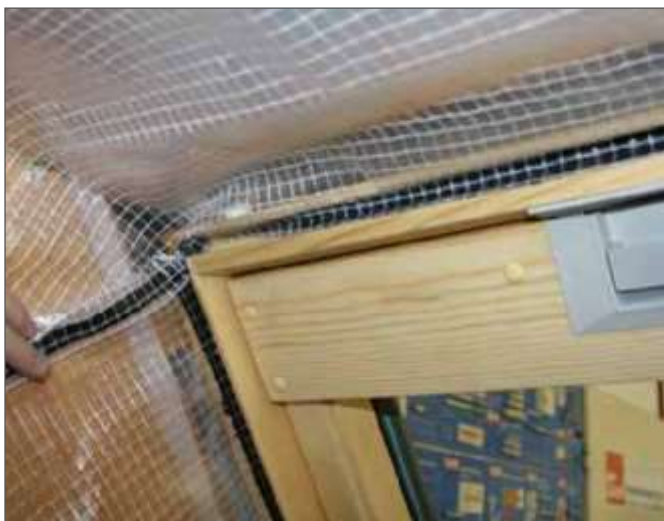
4. Герметизація верхнього кута
