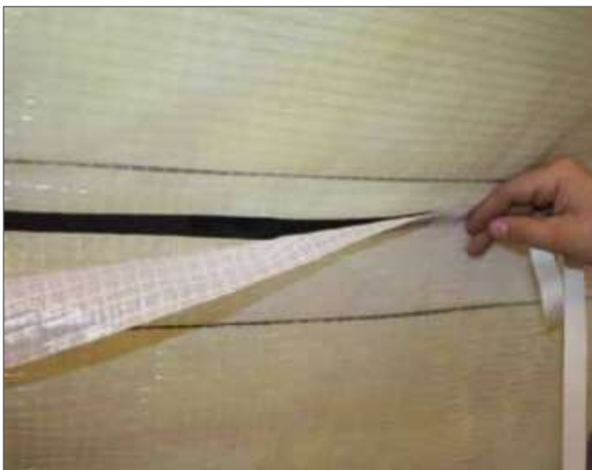
5. Щільно приклеїти верхнє перекриття пароізоляції
