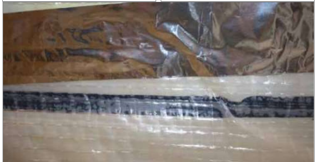
7. Готова конструкція, проклеювання перекриття подвійним способом
