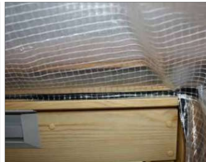
3. Ущільнити примикання перекриття двосторонньою бутилкаучуковою стрічкою
